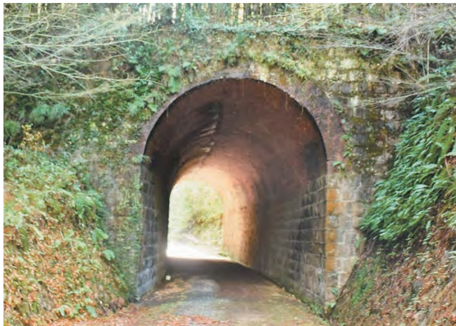
自然に囲まれた大棚トンネル
