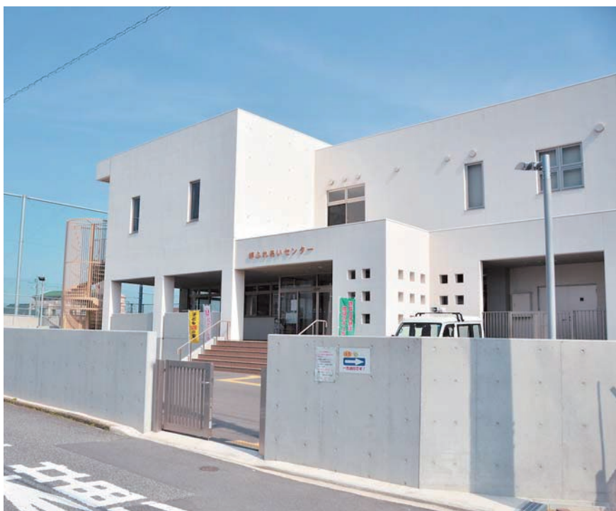
市内初の小学校体育館と合築されたふれあいセンター
